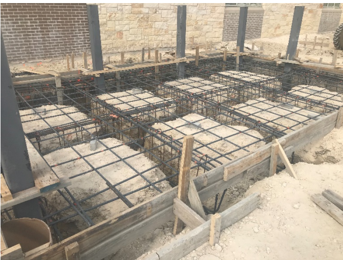
Section 4: Preparing to pour dumpster pad.
