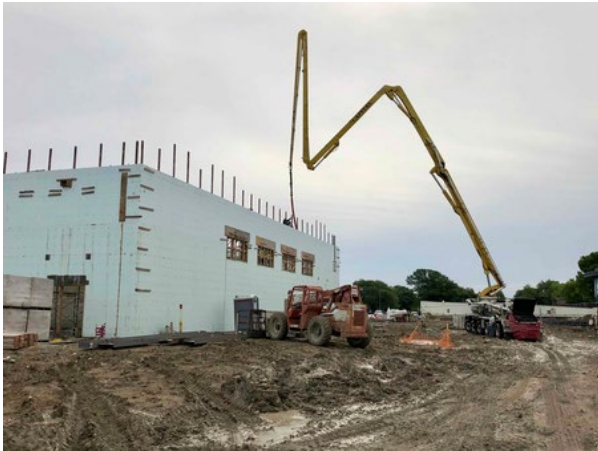
Building: ICF pour on Area 4
