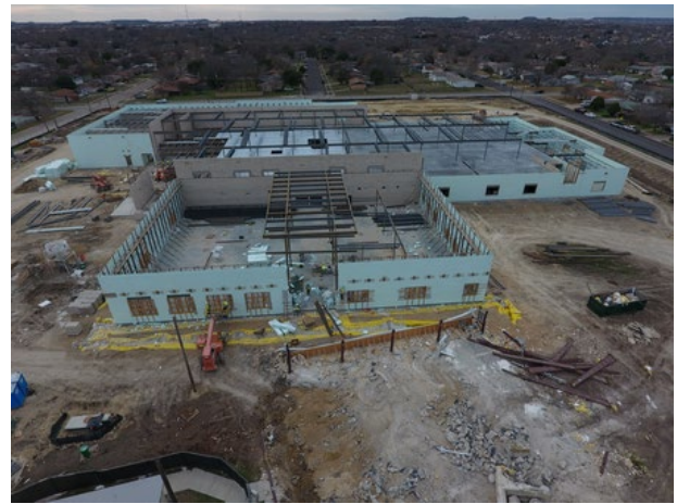
Building: Area 1 ICF framing ready for pour
