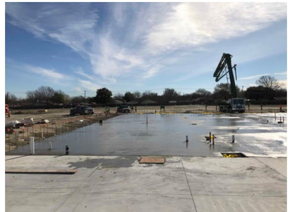
Building: Area 1 slab pour
