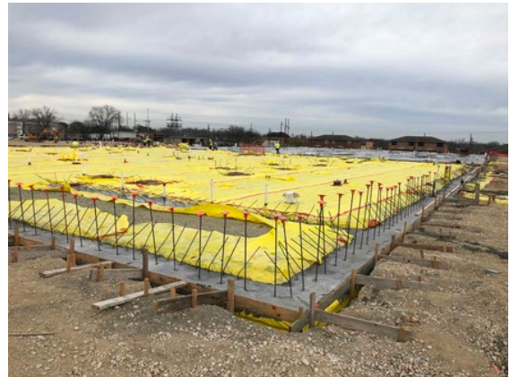
Site: Pest control spray area 2 ready for pour
