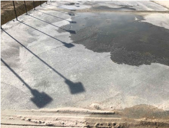
Site: Area 3 slab.
