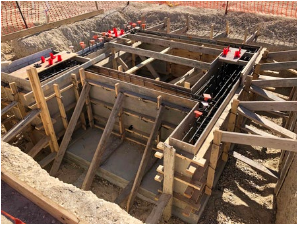
Site: Elevator pit ready to pour
