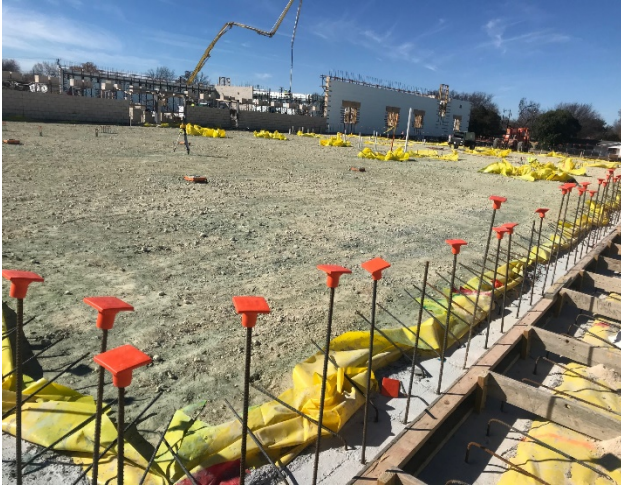
Site: ICF pour area 3
