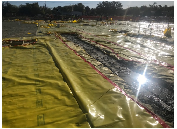
Site: Prep for slab pour
