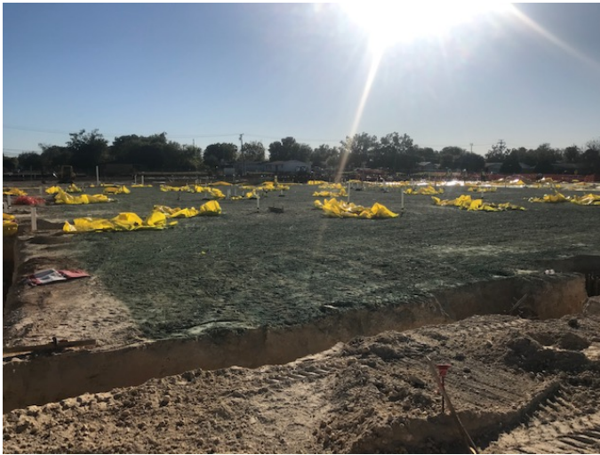
Site: Pest control spray prep for slab pour
