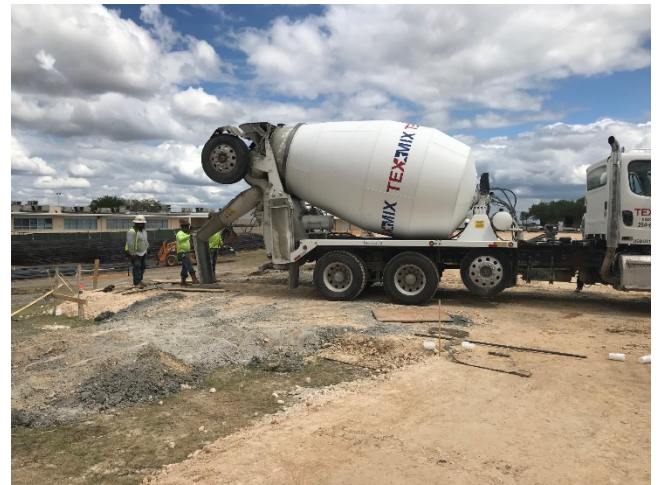
Site: Pouring Piers
